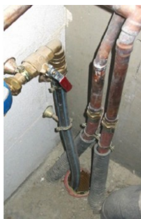
Exemple d'entrées de réseaux à calfeutrer
