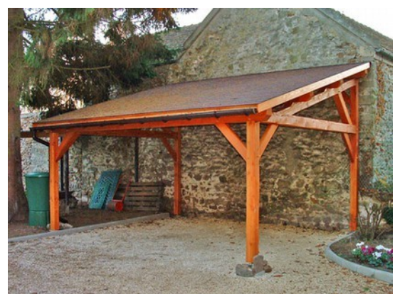
Abri de protection accolé à bâtiment (adjonction)
