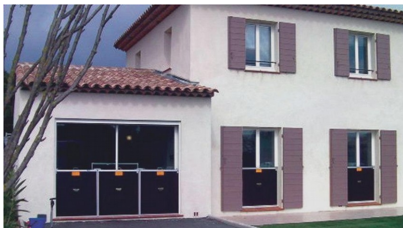
Exemple de protections des ouvertures
